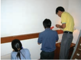
กล่องไม้เก็บสายไฟบนผนังห้อง
